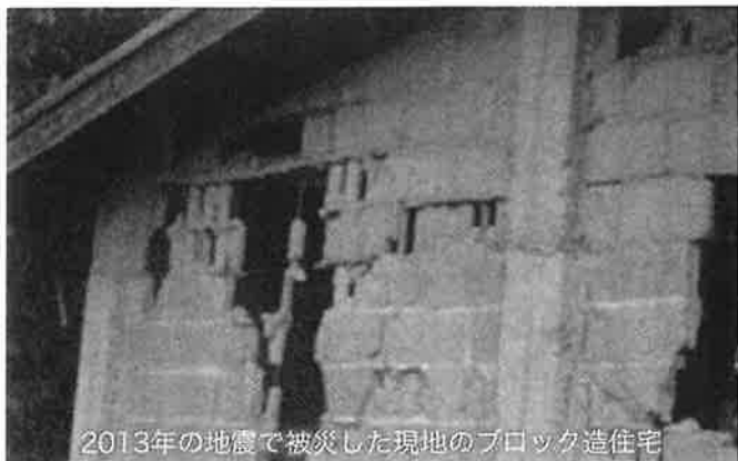
コニットの品質が粗悪であり強くない地震動でも壁面が崩壊
