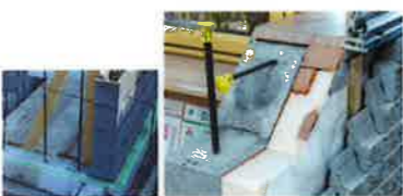
コンクリートブロックの空洞部分に鉄筋を挿入し、そこにモルタルなどを流し込むことでより堅牢な構造に仕上げていく。
